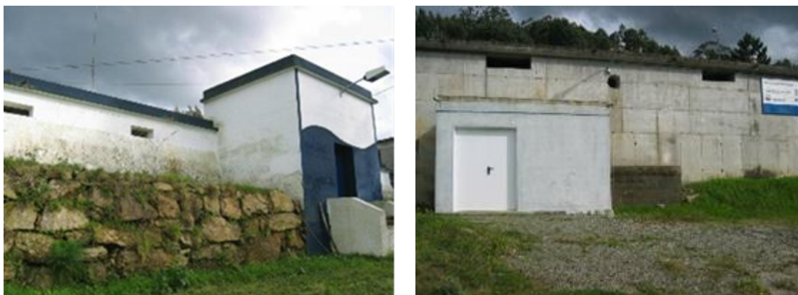
Ilustración 20. Depósito Vello (á esquerda) e depósito Novo (á dereita)
