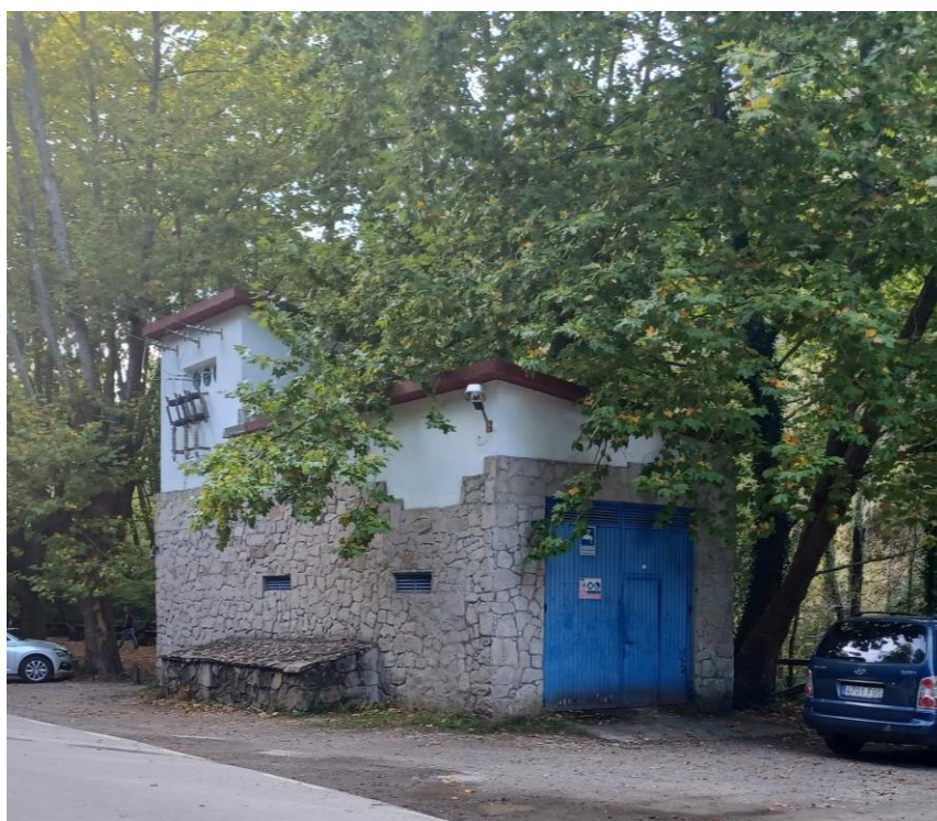
Ilustración 26. Captación Río Eume
