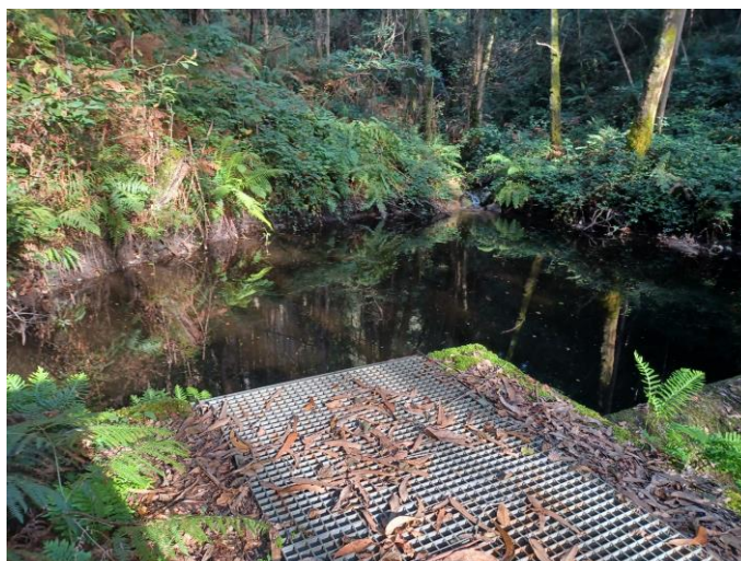
Ilustración 16. Captación mananciais A Chancela
