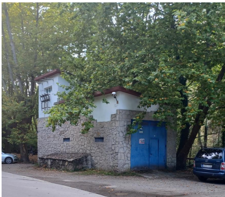
Ilustración 17. Captación río Eume
